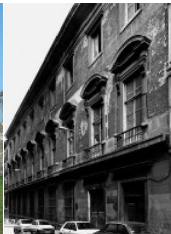
Palacio de Altamira antes da última restauración. Rúa Flor Alta. Madrid < www.memoriademadrid.es >
